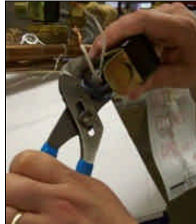
Loosening the conduit nut
